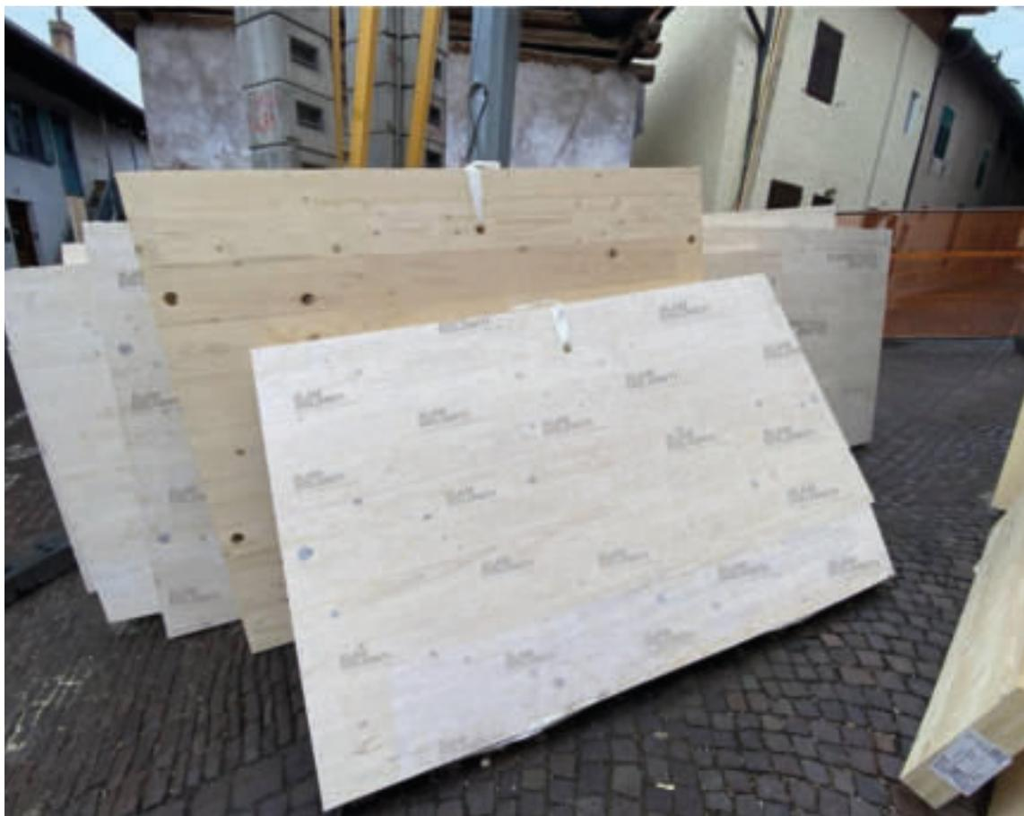
XLAM DOLOMITI è in grado di fornire le pareti o i solai con già applicato il telo di tenuta all'aria o di protezione dall'acqua. La sicurezza di poter applicare i teli in ambiente controllato, garantisce una miglior qualità dell'adesione, evitando così perdite di tempo in cantiere.
